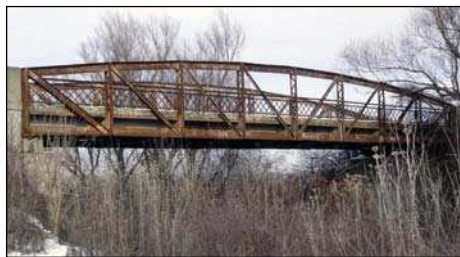
A Kraszna-csatorna vitkai szakasz fölött átvívelő Langer-tartós szegcselt rácsos acélhíd
