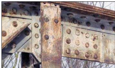
A szegecselts szerkezeti elemek erősen korrodálódtak!!!
